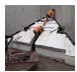
Coulée béton - PEDUZZI / LIVIO
